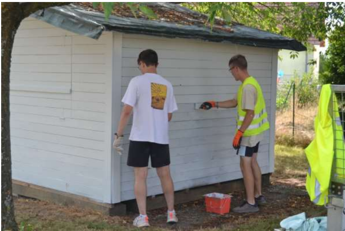
Ponçage et mise en peinture du chalet de stockage sur l'aire de jeux ainsi que du kiosque par nos peintres Loïc et Mathis
